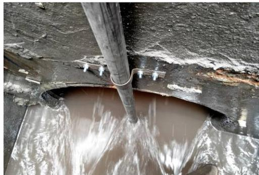
如果是管道内安装，可以不用断水，从管道顶部放支架下去固定。一般的管道在2000毫米以内，可以居中安装，传感器用支架固定在管道底部。支架要做成“L”型，传感器固定在“L”型支架的底部，深入管道内，传感器正对着水流方向。
